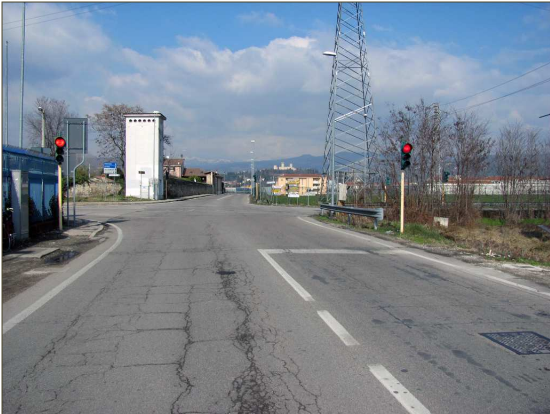
Figura 6: foto stato attuale.
